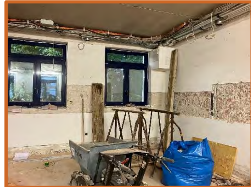
Küche im Umbau:
