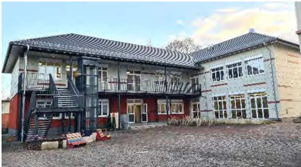
Grundschule Fauerbach, Friedberg
