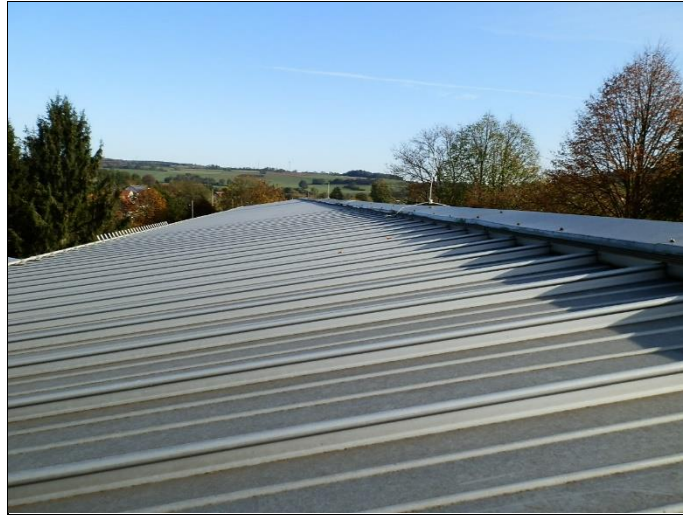
Ansicht Satteldach, ca. 2004
