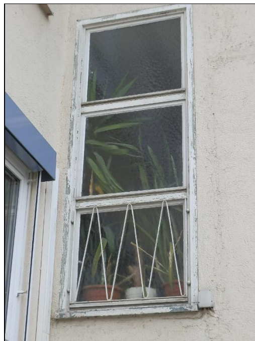
Einfachverglasung Treppen Altbau-Anbau
