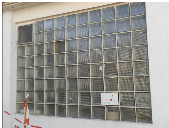
Zwischenbau/schadhafte Glasbausteine
