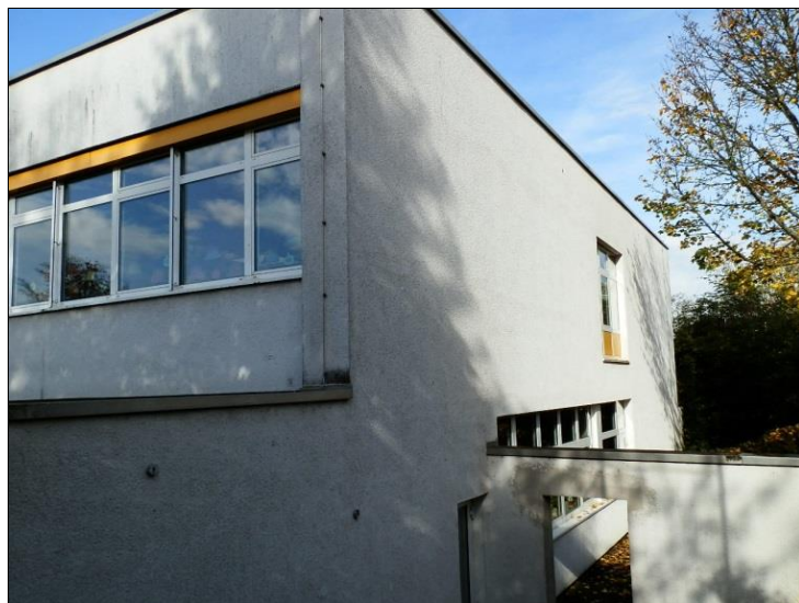
Fassade mit WDVS/Ansicht Ost
