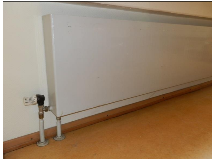
Hauptgebäude/Thermostatventil am alten Heizkörper
