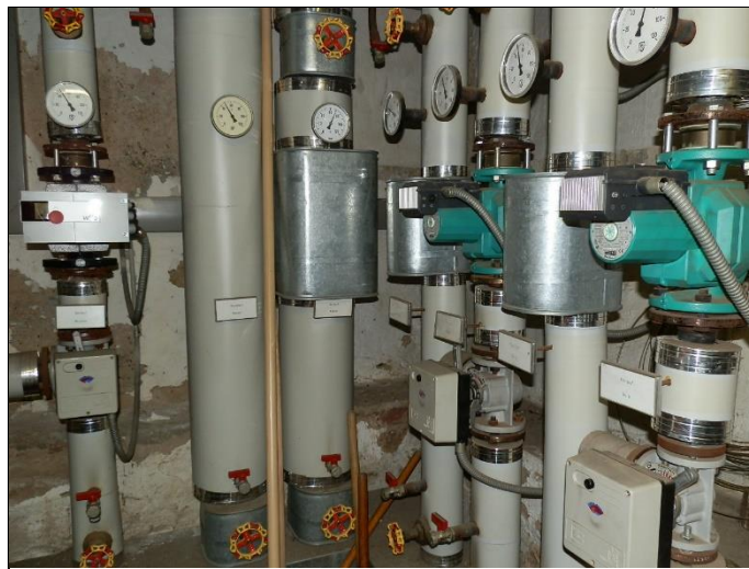
Heizungsverteilung/Umwälzpumpen
