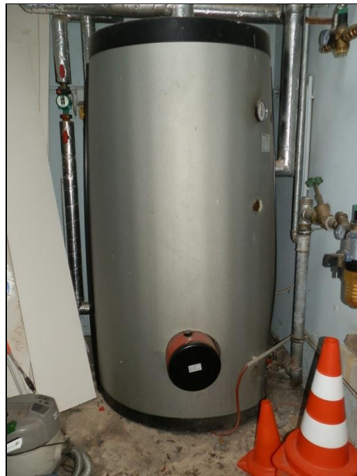
Trinkwarmwasserspeicher
