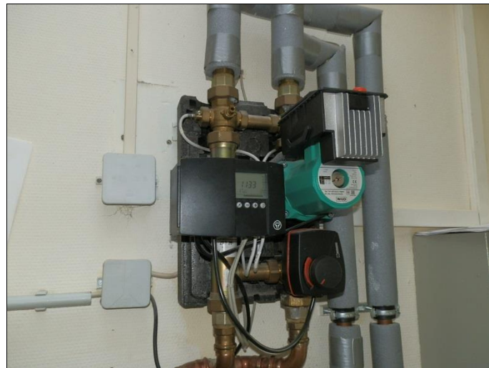
Umwälzpumpe Fußbodenheizung
