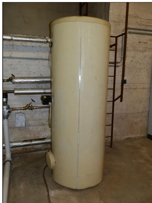
Turnhalle/zentrale Trinkwarmwasserbereitung
