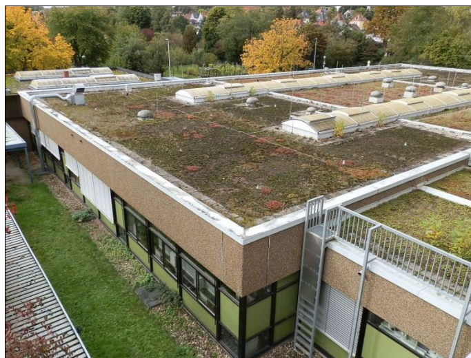
Fassade Flachdach Werkstattgebäude/ca. 2000
