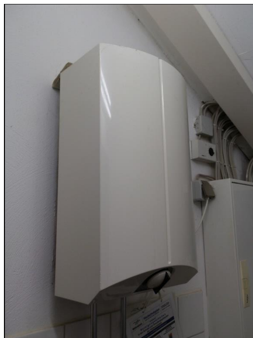
Kleinspeicher 8-Klassen-Bau
