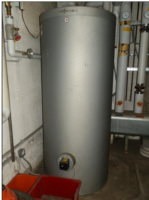
Trinkwarmwasserspeicher
