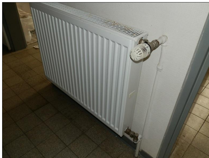
Radiator mit Thermostatventil, nicht voreinstellbar
