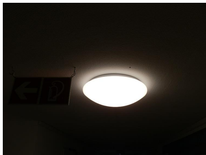
Anbau – Flur / neue LED-Leuchte
