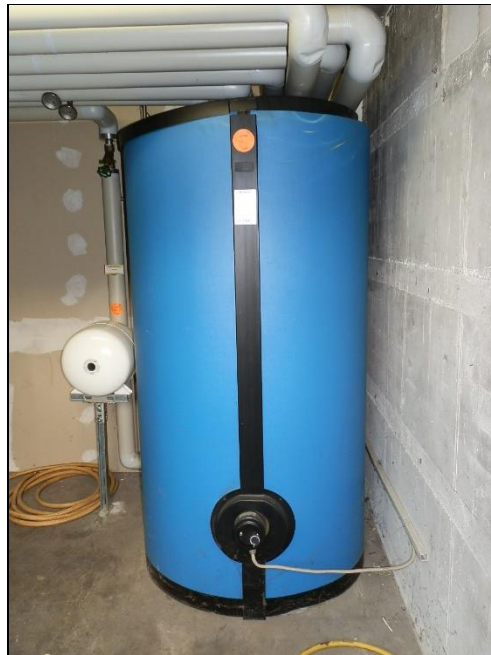
Zentrale Trinkwarmwasserbereitung
