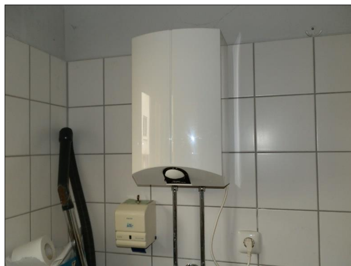
Elektrische Trinkwarmwasserbereitung
