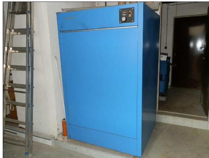
Zentrale Trinkwarmwasserbereitung
