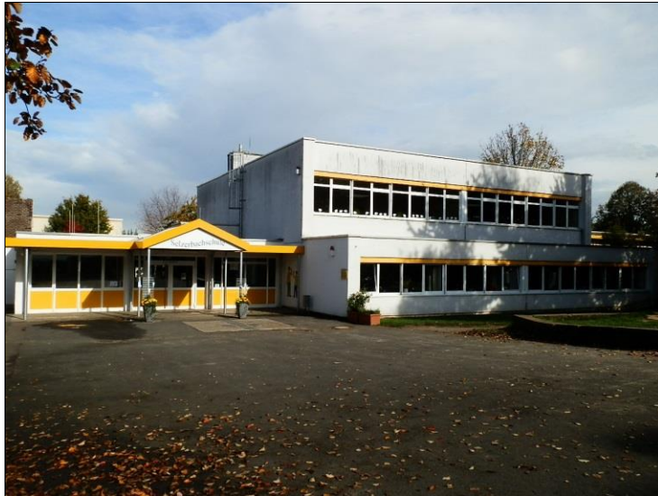
Fassade mit WDVS/Ansicht Süd und West
