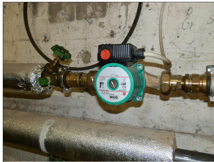
Zirkulationspumpe
