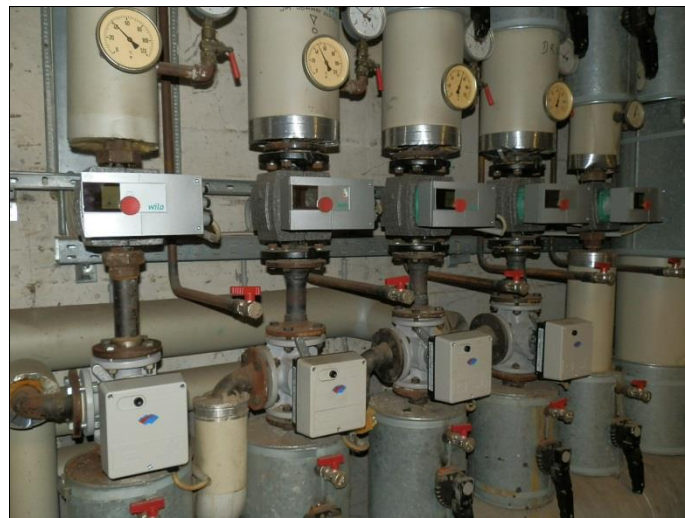
Sporthalle/Hocheffizienzpumpen, Heizungsverteilung
