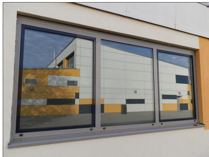
Nordseite/neue Wärmeschutzverglasung dreifach
