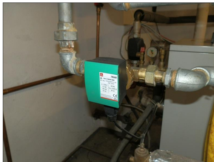
Zirkulationspumpe
