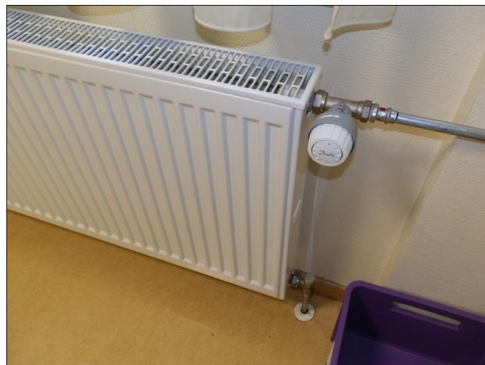
Verwaltung/Radiator mit voreinstellbarem Thermostatventil
