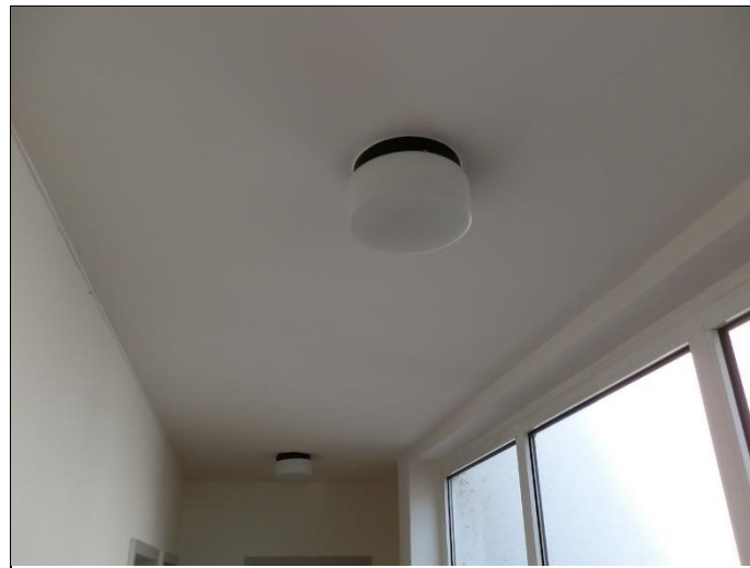
Verwaltung/alte Flurbeleuchtung mit Glühlampen
