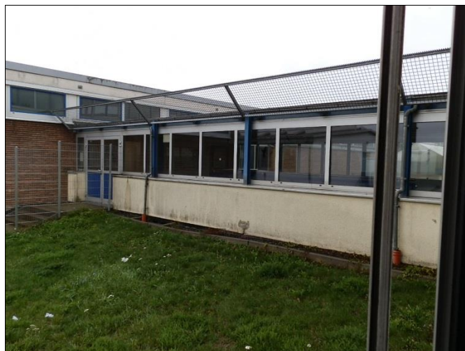
Verbindungsgang mit Wärmedämmverbundsystem
