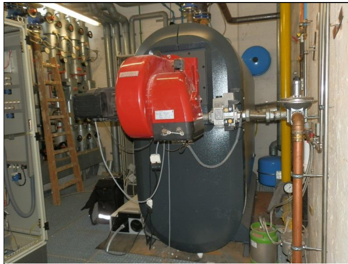
Heizzentrale Altbau/Brennwertkessel
