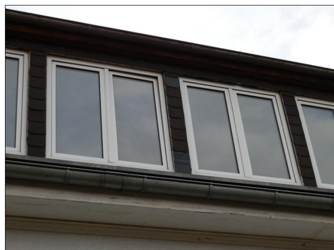
DG/Isolierverglasung ca. 1980
