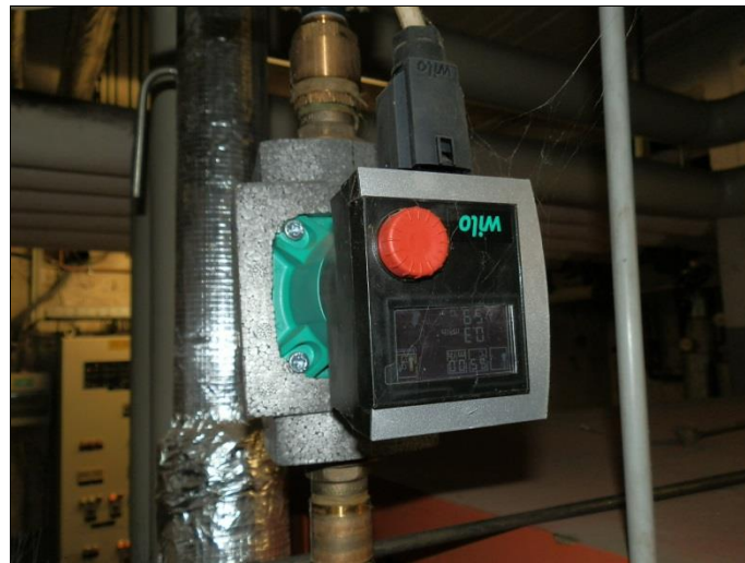
Zirkulationspumpe Sporthalle
