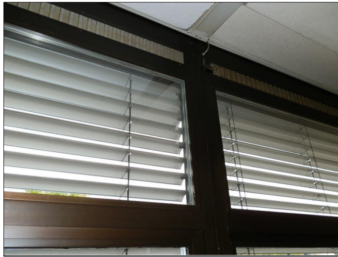
Alte Fenster mit Lüftungsgitter
