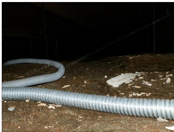
Oberste Geschossdecke/alte Dämmung
