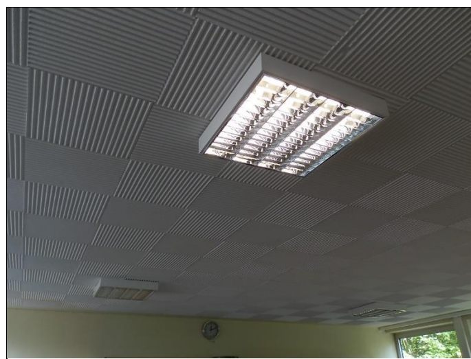
Raster-Anbauleuchten mit T8-Lampen
