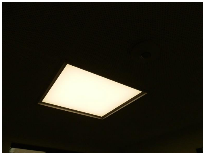
Verwaltung – Flur / neue LED-Leuchte
