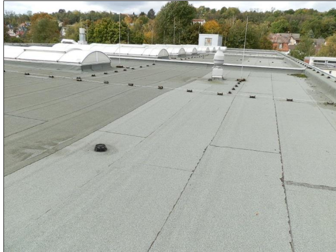
Ansicht Flachdach Unterrichtsgebäude/ca. 2009 - 2011
