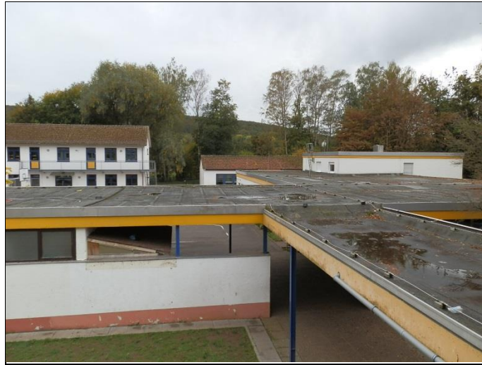
Verwaltung, Außengebäude, Überdachungen / Flachdächer
