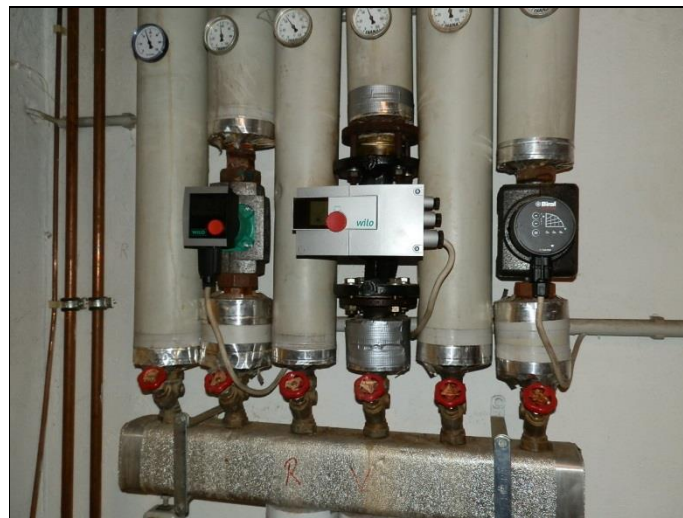
Umwälzpumpen/Heizungsverteilung
