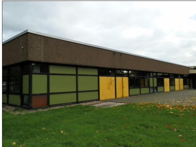
Fassade/Ansicht Süd-West, alt
