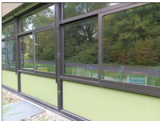
Alte Fenster- und Fassadenelemente 1974
