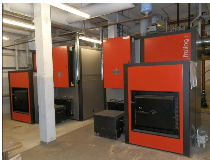
Heizzentrale/Pelletkessel
