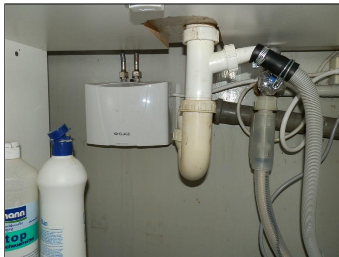
Hauptgebäude/Durchlauferhitzer
