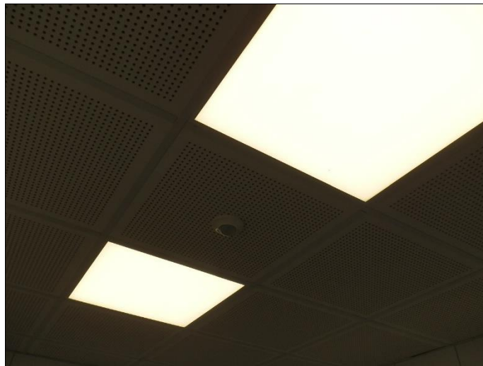
Neue LED-Leuchten mit Bedarfssteuerung über Präsenzmelder
