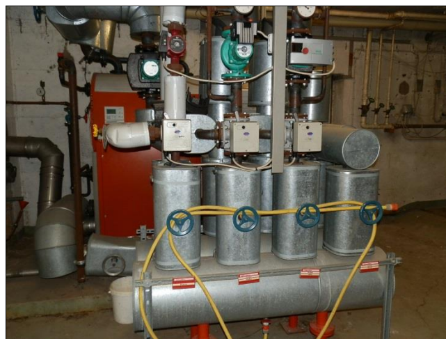
Heizungsverteilung/Umwälzpumpen
