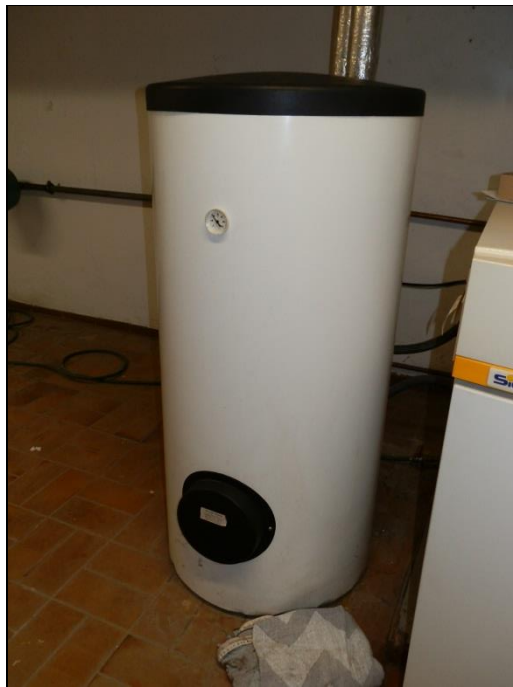
Zentrale Trinkwarmwasserbereitung
