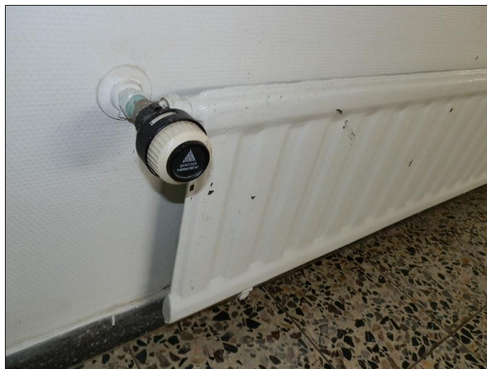
Thermostatventil ohne Voreinstellung
