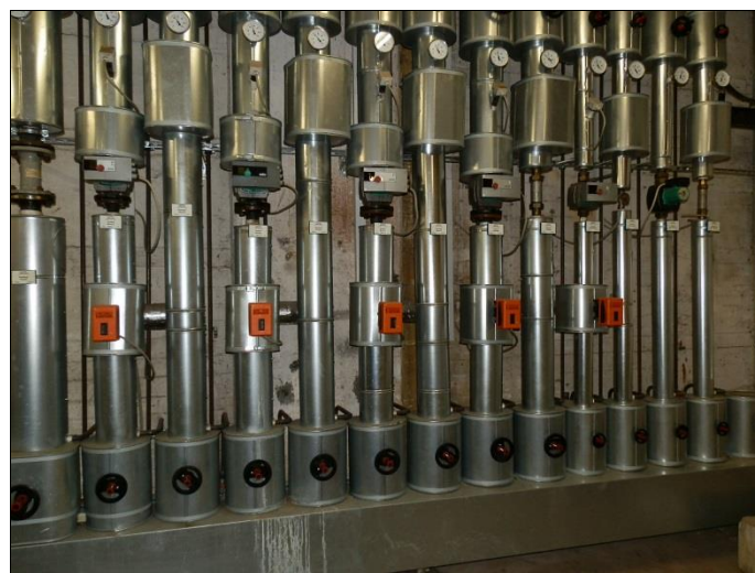
Heizungsverteiler/Hocheffizienzpumpen
