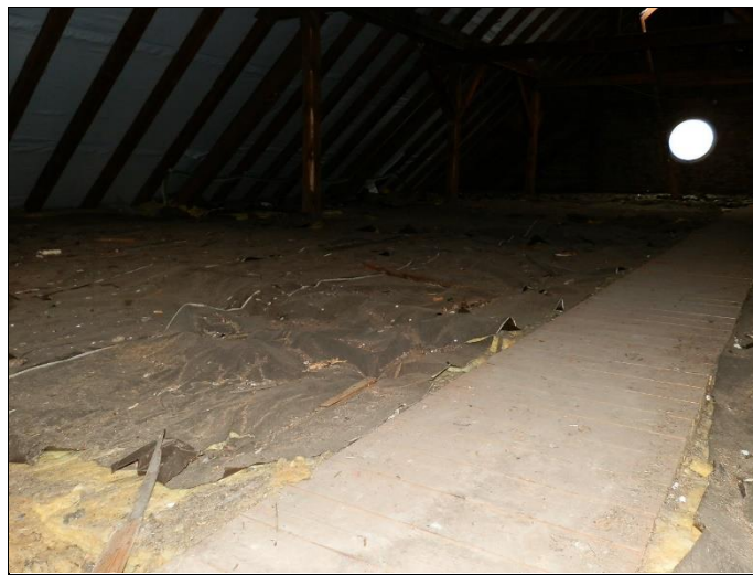
Dämmung oberste Geschossdecke
