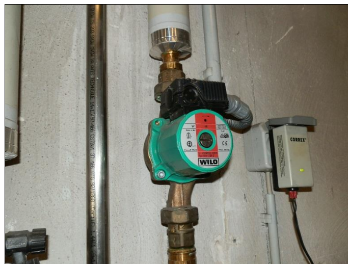
Warmwasserzirkulationspumpe
