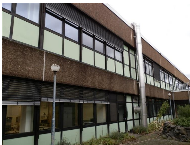
Fassade/Ansicht Süd-West, neue Elemente ca. 2005 - 2010
