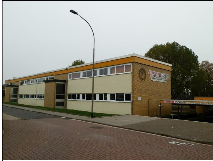
Fassade/Ansicht Nord und West
