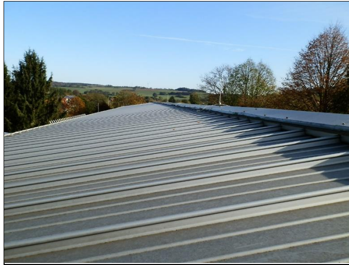
Hauptgebäude/geeignete Dachfläche für die PV-Anlage
