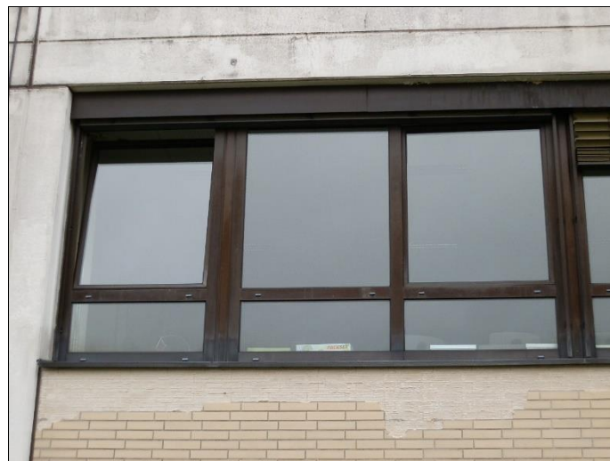
Alte Isolierverglasung 1982
