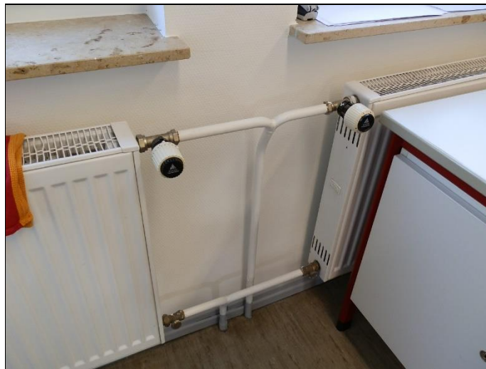
Fachtrakt/Thermostatventile ohne Voreinstellung
