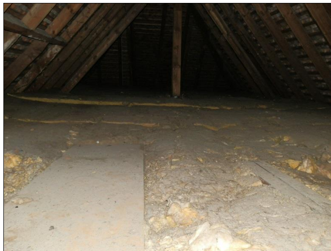
Dämmung oberste Geschossdecke
