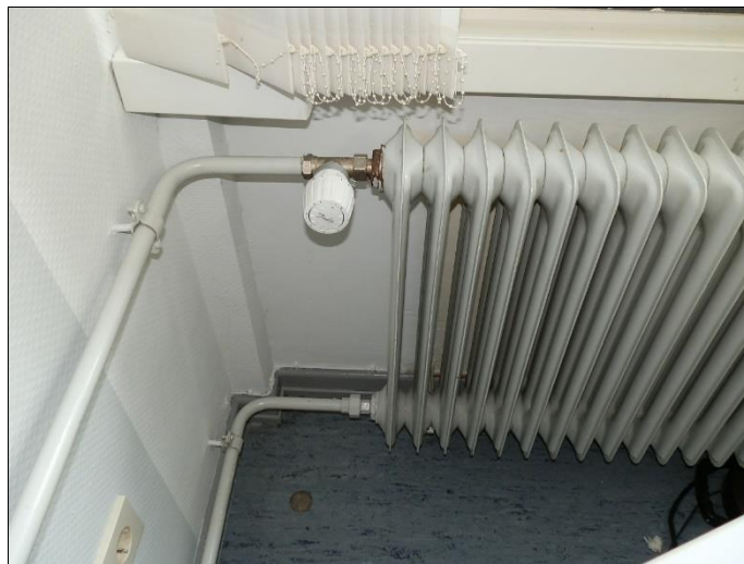
Thermostatventil, neueres Modell
