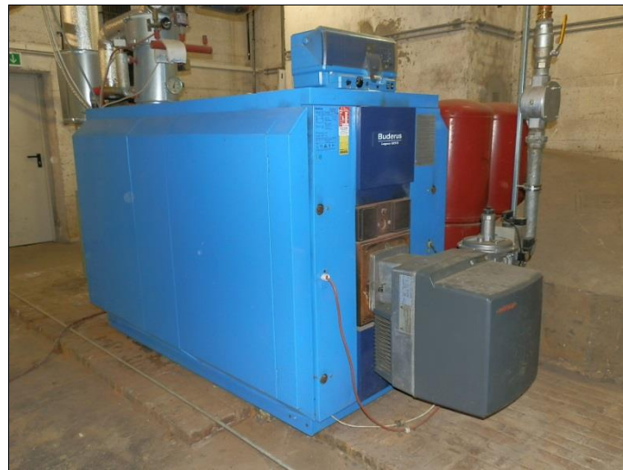
Niedertemperaturkessel Heizzentrale
