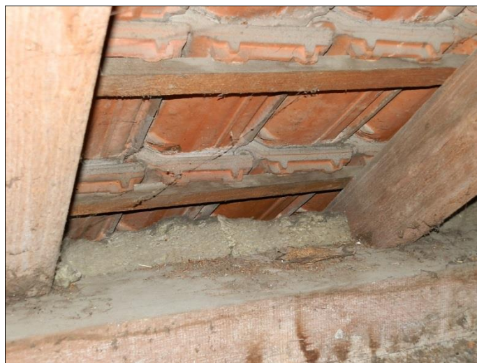
DG/ausgebauter Bereich mit Dämmung
