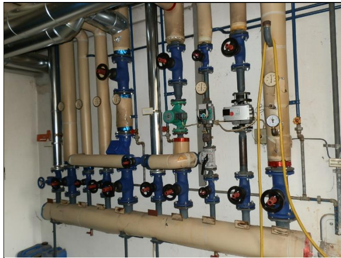
Sporthalle/Heizungsverteilung, Umwälzpumpen
