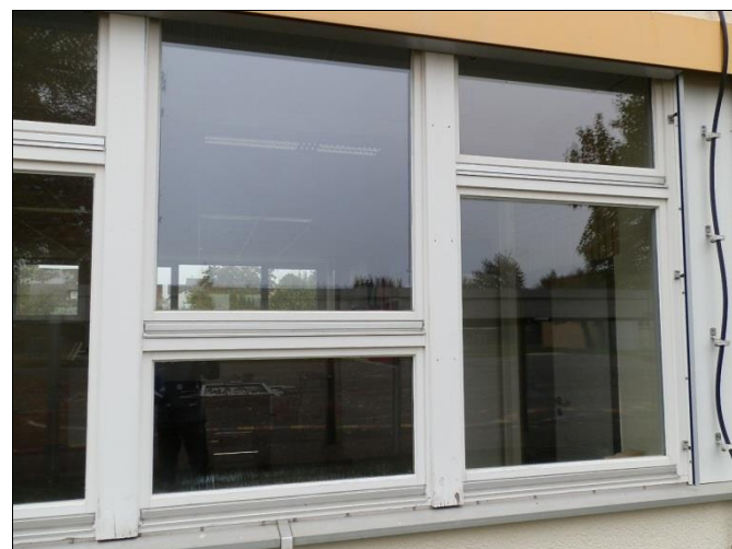
Hofseite/Isolierverglasung ca. 1990 bis 1995
