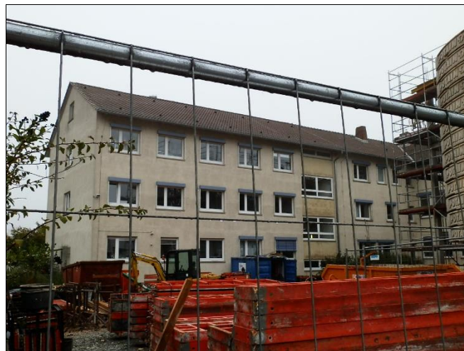
Fassade/Ansicht Süd-West und Nord-West
