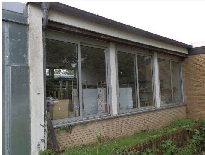
Werkstattbau/alte Isolierverglasung
