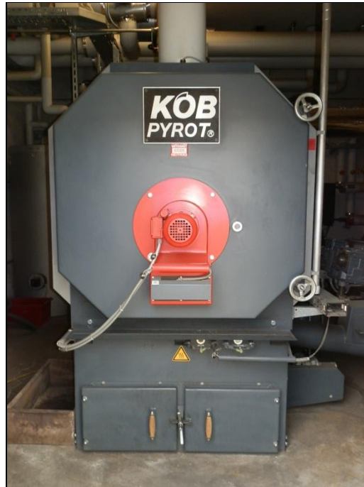
Sporthalle/Pelletkessel
