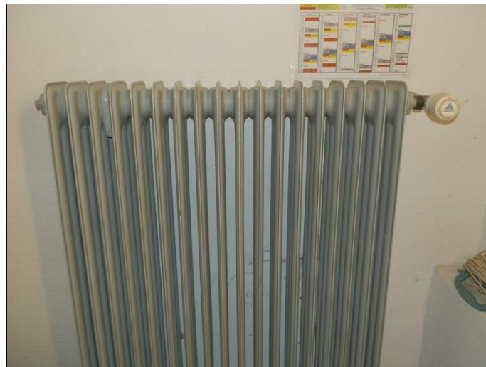
Stahlheizkörper mit Thermostatventil, nicht voreinstellbar
