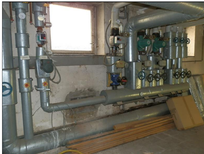
Umwälzpumpen/Heizungsverteilung
