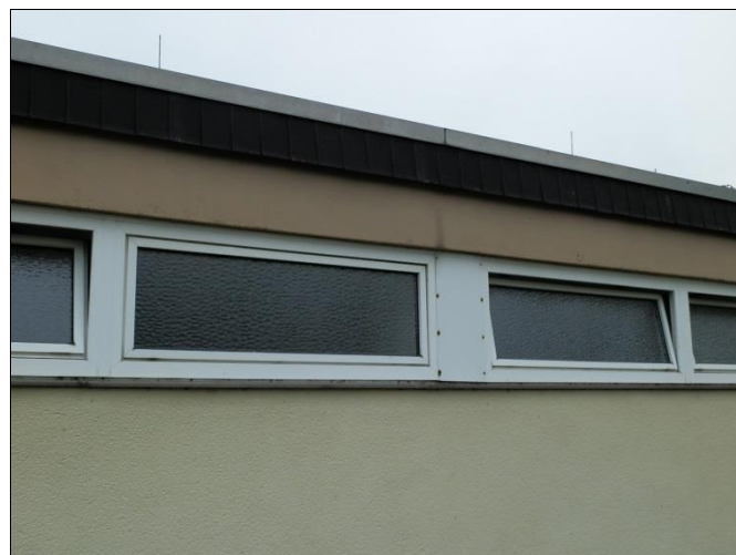
Alte Isolierverglasung
