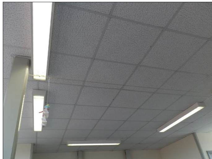
Altbau/Rasterleuchten im Klassenraum DG
