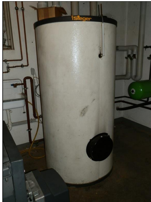
Zentrale Trinkwarmwasserbereitung
