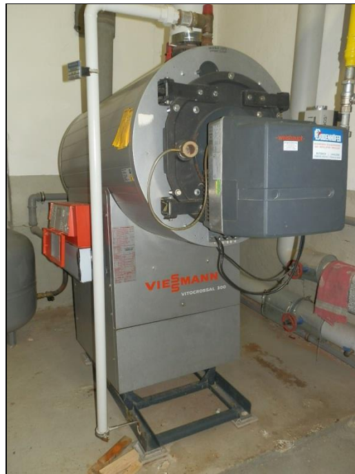
Altbau/Brennwertkessel
