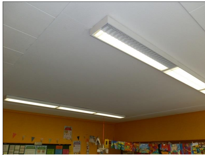
Klassenraum/Raster-Aufbauleuchten mit T8-Lampen und EVG
