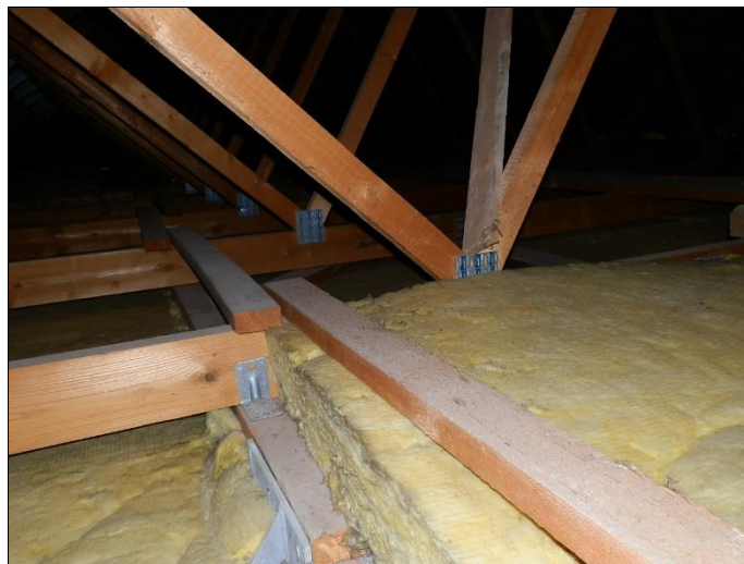
Dämmung oberste Geschossdecke
