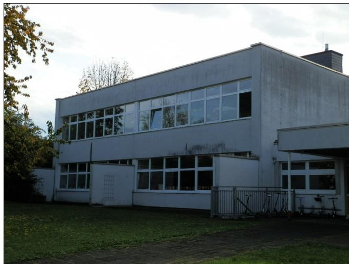
Fassade mit WDVS/Ansicht Nord
