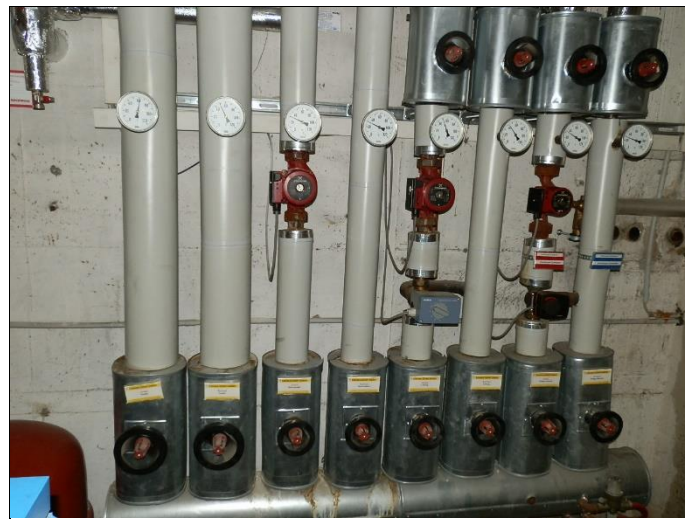
Umwälzpumpen/Heizungsverteilung
