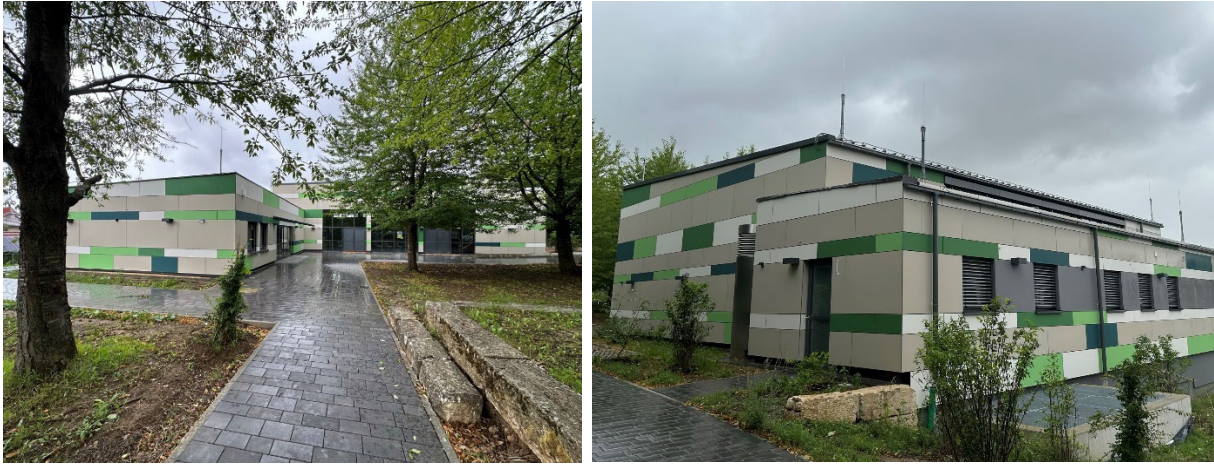
Abb. 15 und Abb. 16: Neubau der Aula Georg-Büchner-Gymnasium
