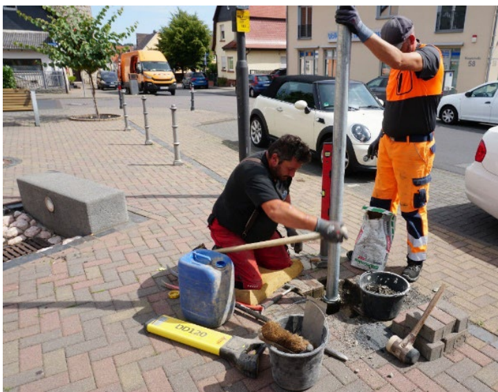
Abb. 37: Arbeiten zur Neubeschilderung
